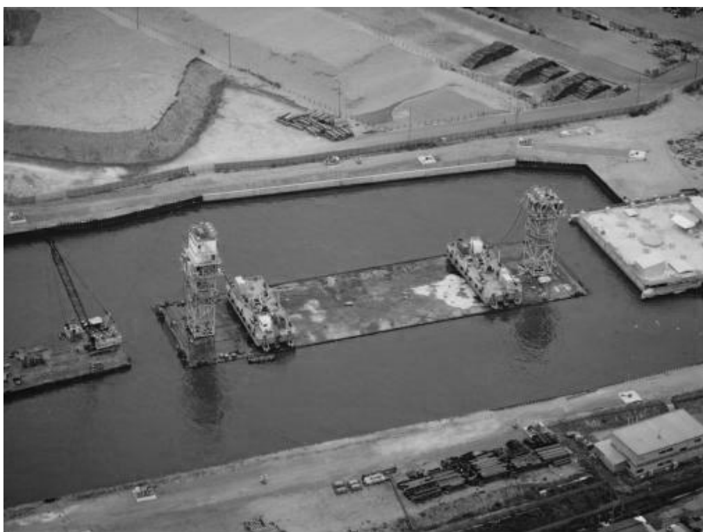
写真-5.2 タワーポンツーン方式による沈設状況
