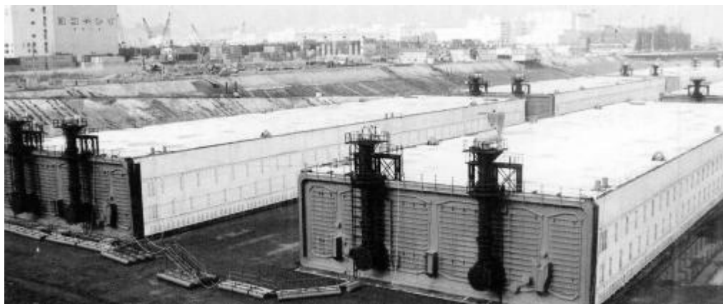
写真-5.1 沈埋函製作状況
