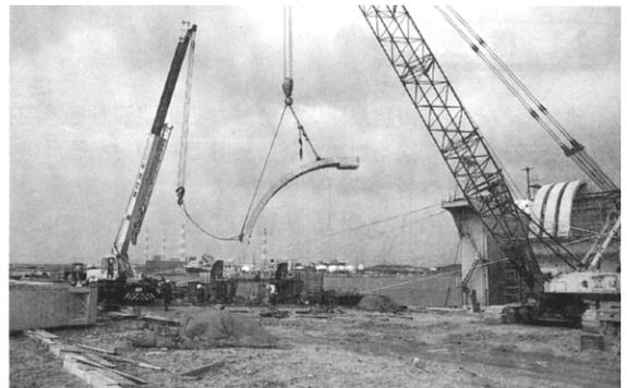
写真 - 3.2 曲面梁設置状況
