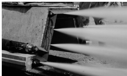
ジェット工法(先端金具使用)
